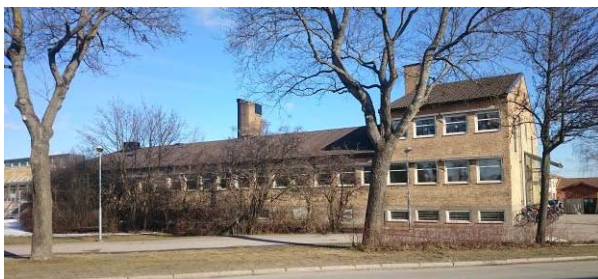
Kontorshus vid Säbygatan.
