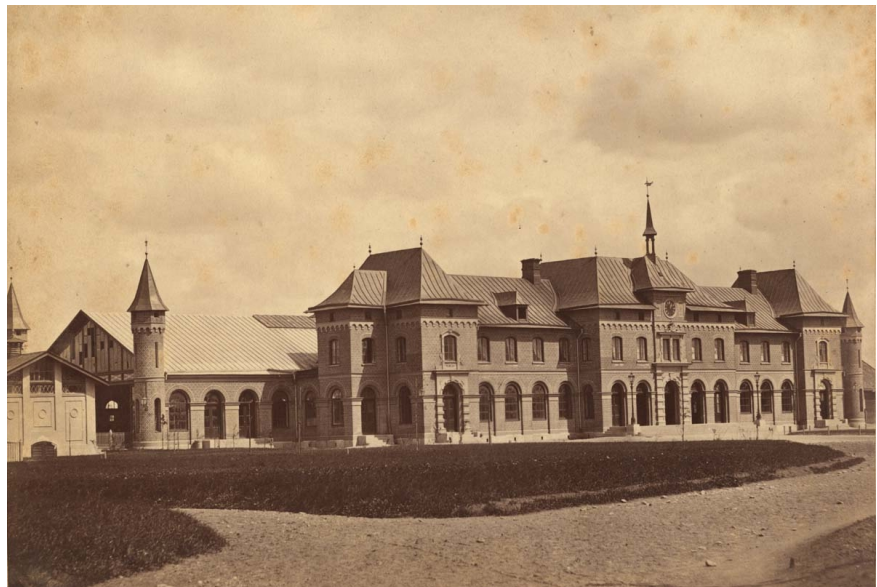
Stationshuset sett från Stadshusgatan. Banhallen i bakgrunden. Okänd fotograf (utan årtal).
