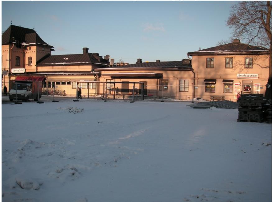
Stationshuset (2005-11-17). Föreslagen rivning gäller den södra delen av stationshuset (i bildens högra del). Tvåvåningshuset och envåningshuset i mitten rivs. Byggnadskroppen närmast det ursprungliga stationshuset byggs om samtidigt som taket bibehålls.
