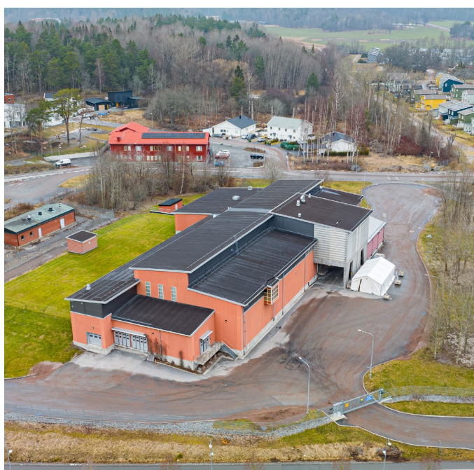
Figur 4 Flygfoto över befintlig byggnad på fastigheten.
