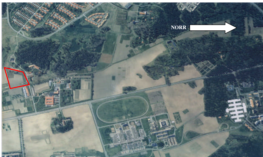
Figur 2. Flygfoto över Bäcklösa med vattenverkets placering.
