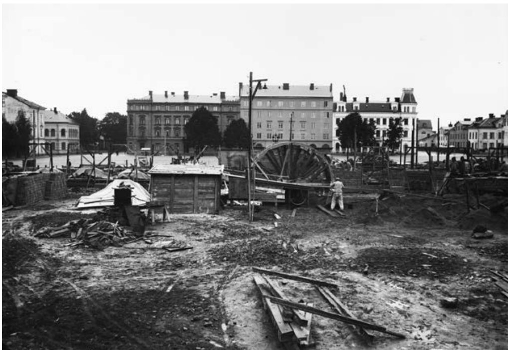
Figur 18 Kvarteret Njord under byggandet av Vaksalaskolan 1925. (Foto: Paul Sandberg, Upplandsmuseet)
