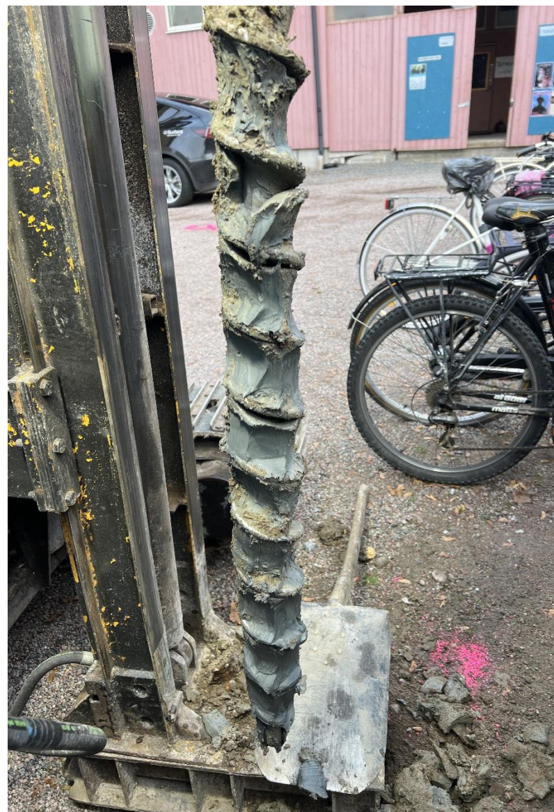
Bild 2: Provpunkt 24DM01 3-4 m, sulfidlera. Borrstopp vid 4 m. Grundvattenrör har installerats i punkten.
