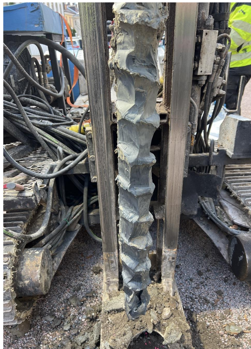
Bild 4: Provpunkt 24DM02 3-4 m, sulfidlera. Borrstopp vid 4 m.
