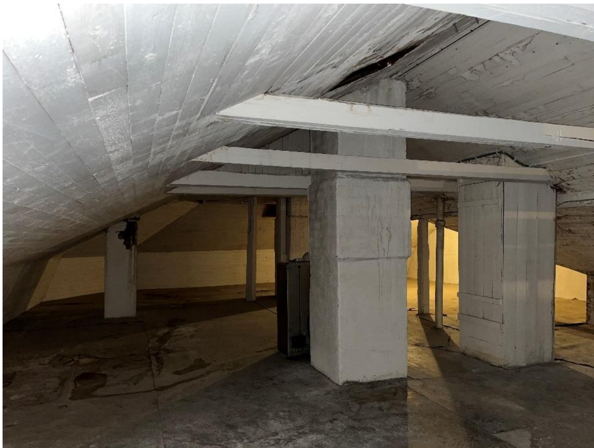
Vindsutrymme från påbyggnaden 1917.
