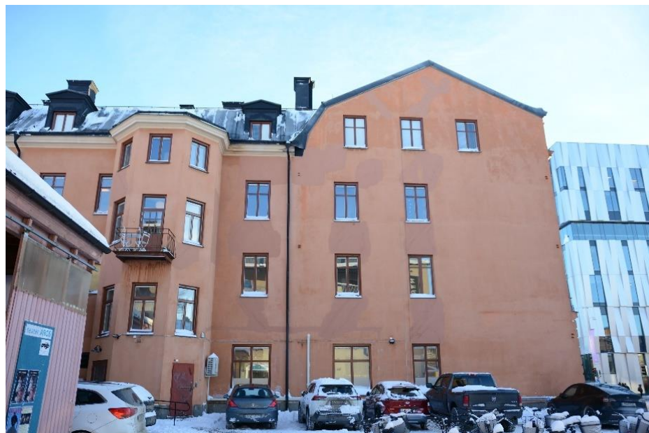
Enklare gårdsfasad med utanpåliggande trapphus.
