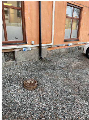
Stuprör vilket leder vatten ut på grusparkeringen
