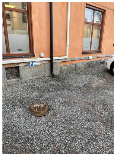
Stuprör vilket leder vatten ut på grusparkeringen
