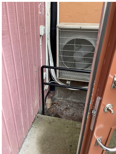
Nedgrävt stuprör på innergården
