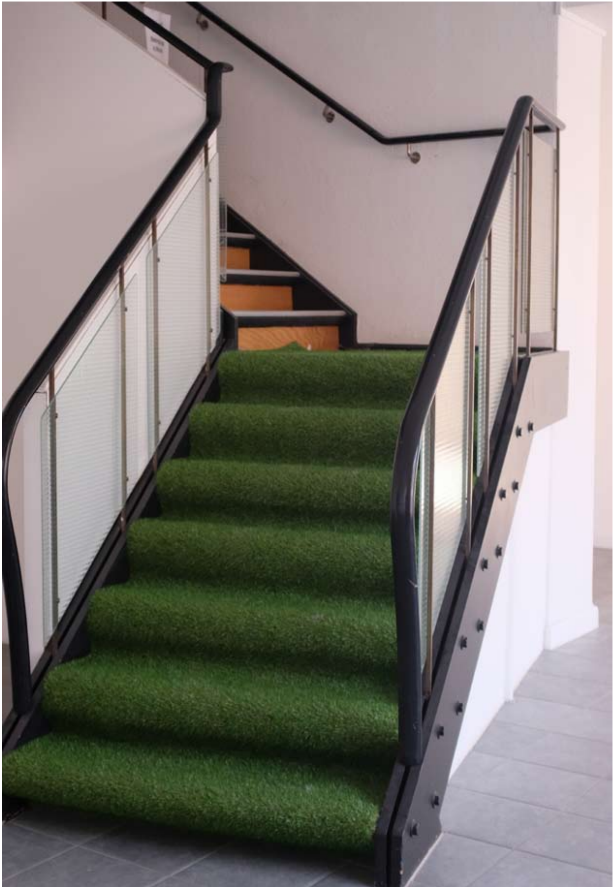
Trappa mellan affärslokalen i bottenplan och utställningslokalerna på plan 1. Trappan är av bygglörshandlingar att döma uppförd på 1950-talet, vilket stämmer väl överens med dess utseende. Trappträcket har en överliggare klädd i svart plast, ständare i mässing och sidor av pansarglas. Den gröna mattan är dock sentida.
