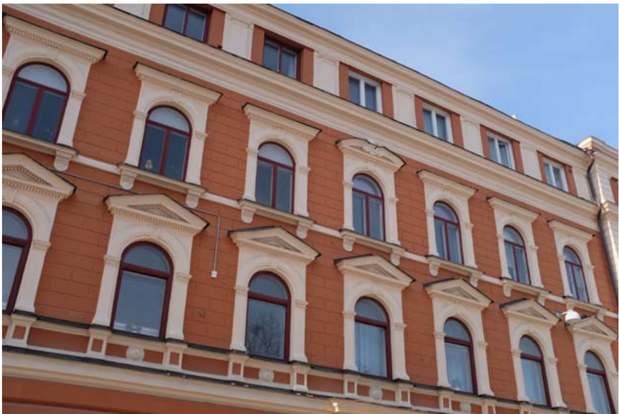
Parti av fasaden mot torget. Fasaden målades om 2010. Färgsättningen saknar hävd. Notera att de nedre bågarna på plan 1 har bytts. Dessa var ursprungligen lika fönstren på våningen över. På den översta våningen har de fyra fönstren längst till höger bytts till moderna fönster, sannolikt relativt nyligen. Fasaden har många bevarade detaljer i putsornamentiken.
