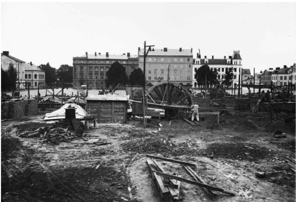
Kv Njord under byggandet av Vaksalaskolan 1925. Foto Paul Sandberg. Upplandsmuseet.
