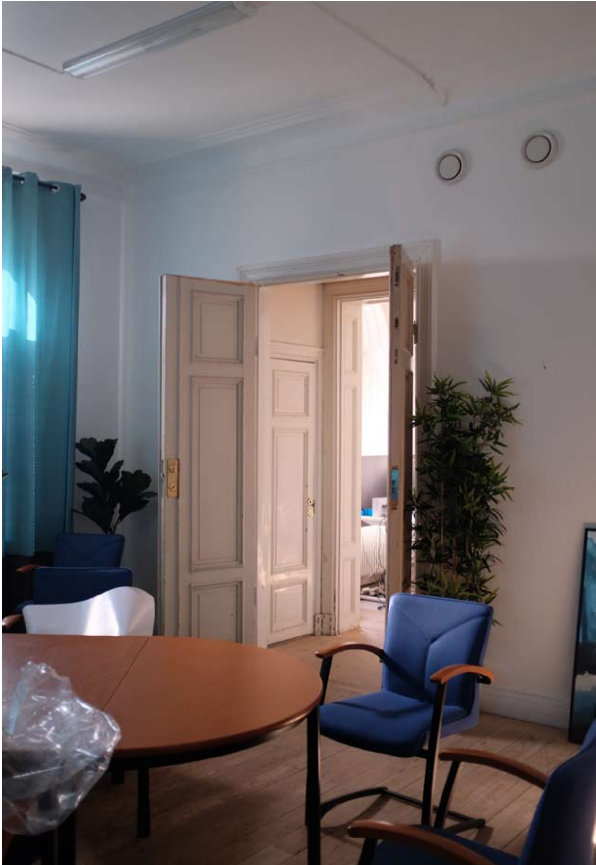
Interiörbild från plan 1 (jfr bild på s. 14). Golvet har tidigare varit belagt med fiskbensparkett. Pardörrarna och dörrarna inne i dörrsmyn är ursprungliga, liksom lister och det synliga undergolvet. Sentida hysrörsarmatur i taket, samt ventilationsdon på väggen.
