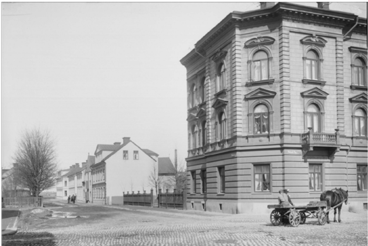
Korsningen Salagatan-Vaksalagatan mot nordväst 1901. Den tänkta byggnadsdelen mot Salagatan kom aldrig till utförande, istället avskärmas gården med ett staket. Foto Alfred Dahlgren. Upplandsmuseet
