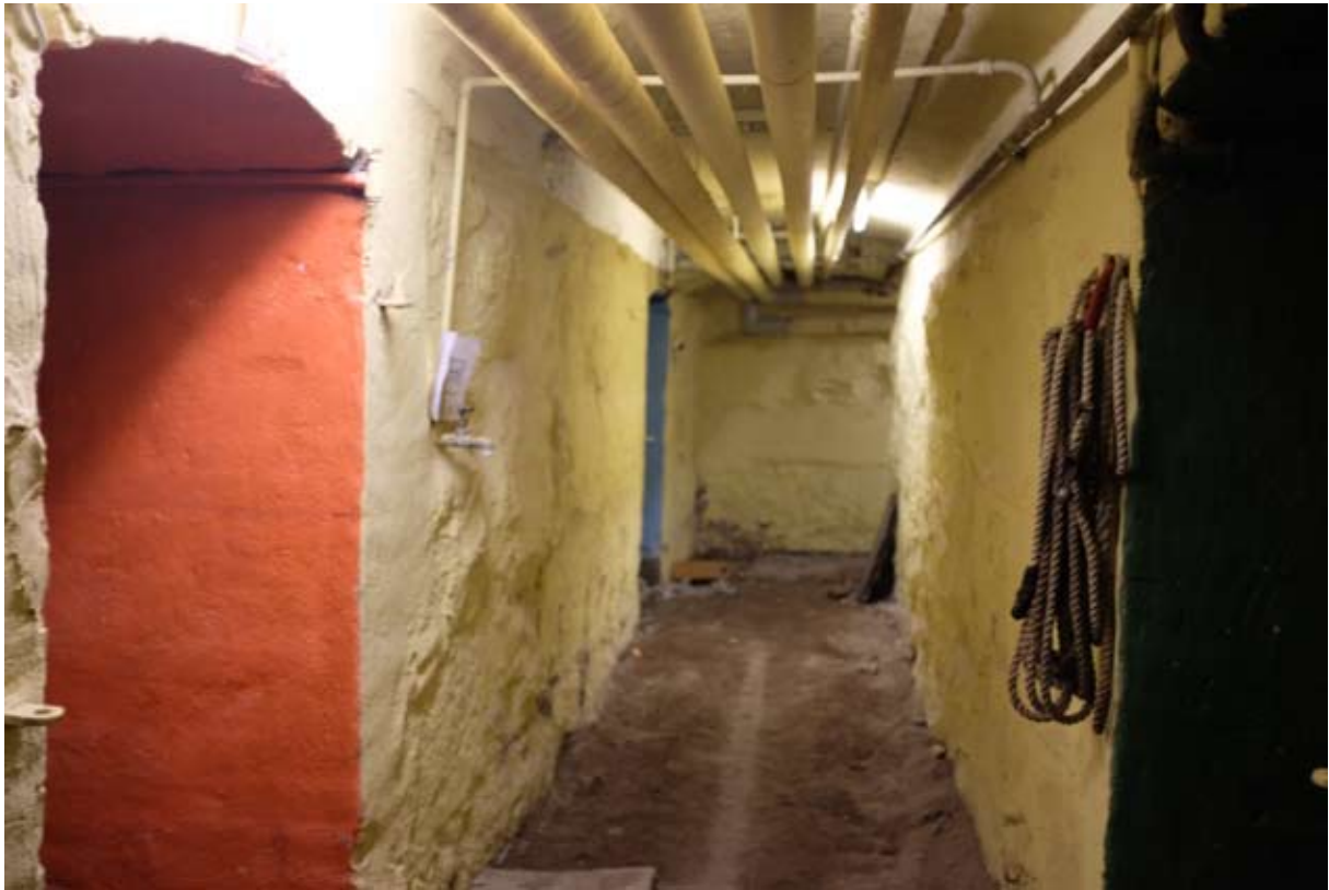
Interiör från källaren. Notera jordgolvet!
