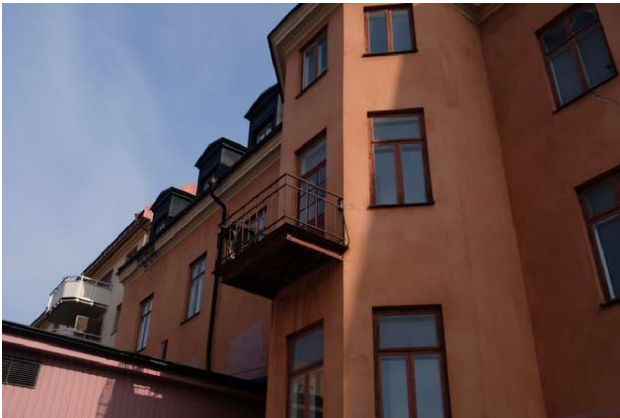
Trappbustornets balkong är sekundär. Av utseendet att döma är den uppförd någon gång under 1900-talets första hälft.
