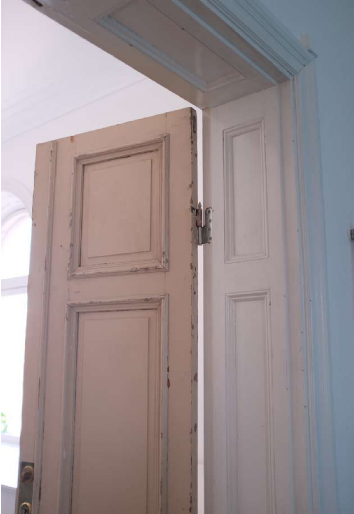
Detalj av pardörr på plan 1. Beslagningen är huvudsakligen sekundär.
