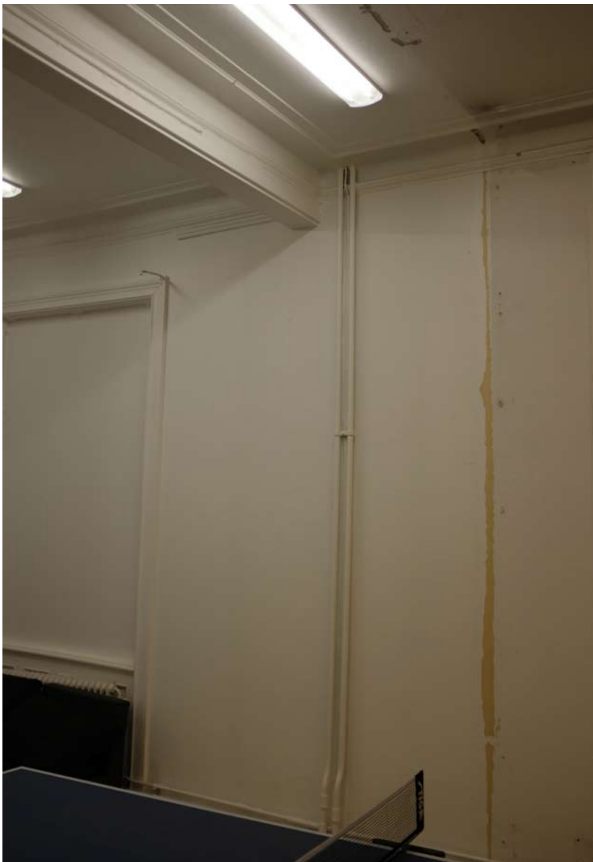
Interiör från bottenplan (?). Inredningen visar tydliga spår av flera förändringar över lång tid, såsom ändrade vägglägen, igensatta fönster- och dörröppningar, nya och äldre el- och vattaendragningar etc.
