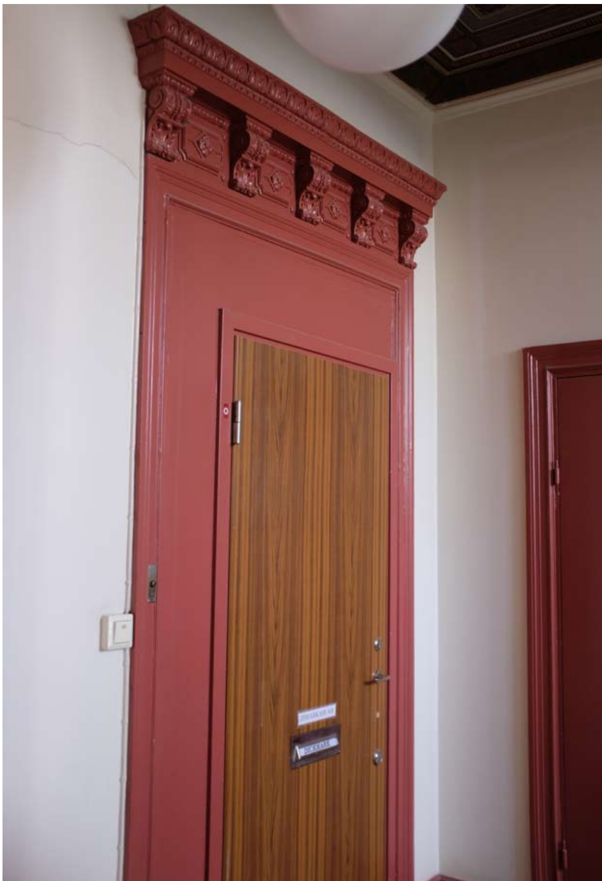
Lägenhetsdörr i trapphuset. Dörrumfattningen visar att dörrarna ursprungligen har varit deurbattanter, pardörrar, förmodligen lika rikt utsirade som de bevarade kornisberna. Vid något tillfälle har dessa ersatts med enkeldörrar av modernt snitt. Dörren på bilden är en säkerhetsdörr av sentida modell.
