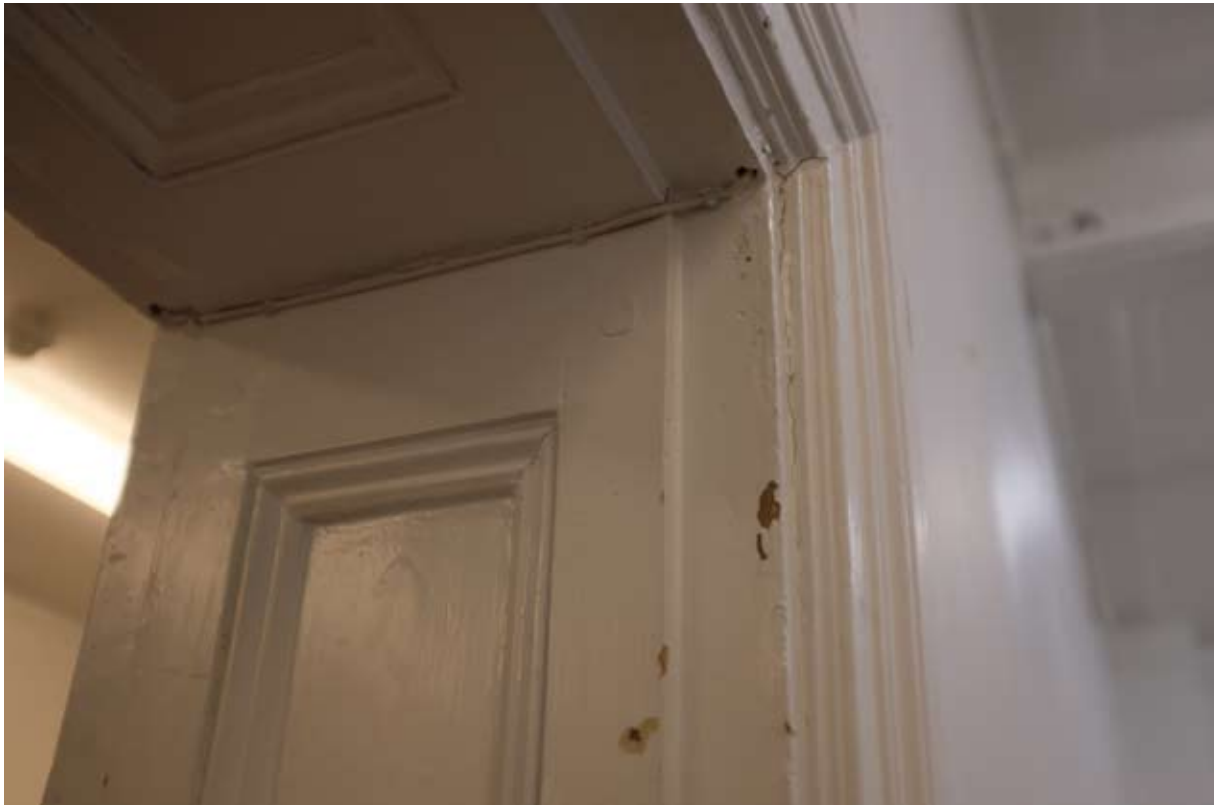
Detalj av panel i dörrsmyg.
