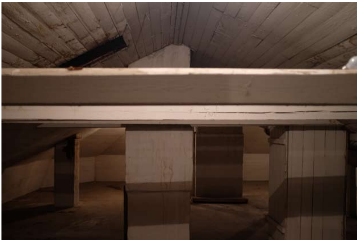
Interiör från vinden. Den nuvarande vinden tillkom i samband med att huset byggdes på med en våning 1917.
