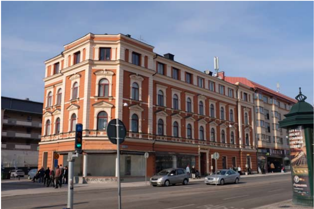
Byggnaden från söder, hörnet Salagatan Vaksalagatan. Den högra delen är fasaden mot Vaksala torg. Fasaden är rikt ornamenterad med bandrusticering i bottenvåningen, rusticerade hörnkedjor och dito väggfält på övriga våningsplan. Fönsteromfattningarna på plan 1 och 2 är utformade som frontoner respektive brutna segmentbågar eller kornischer.
