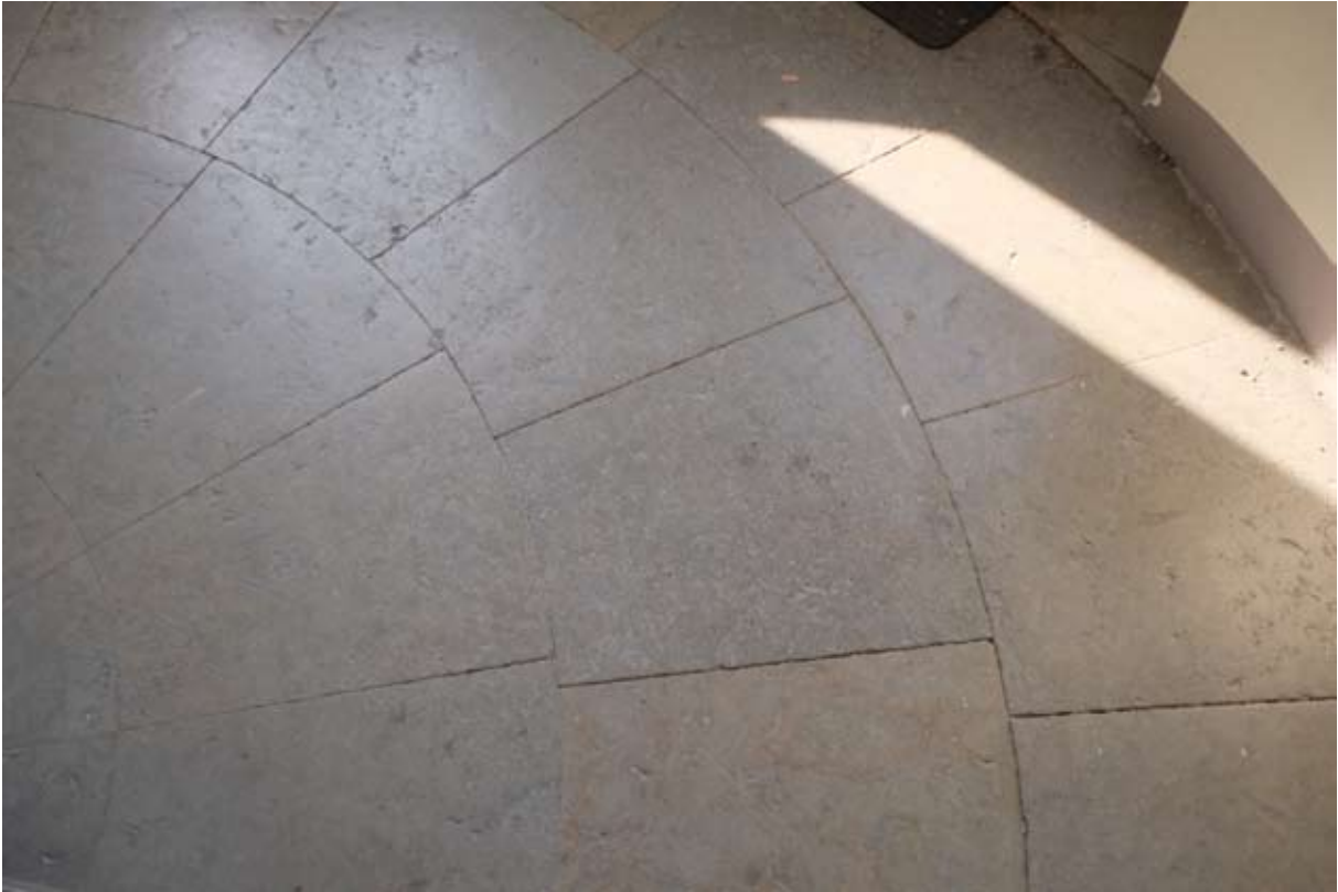
Trapphuset har golv av kalkstensplattor i öländsk kalksten. Golvsocklar saknas, istället finns en målad sockel.
