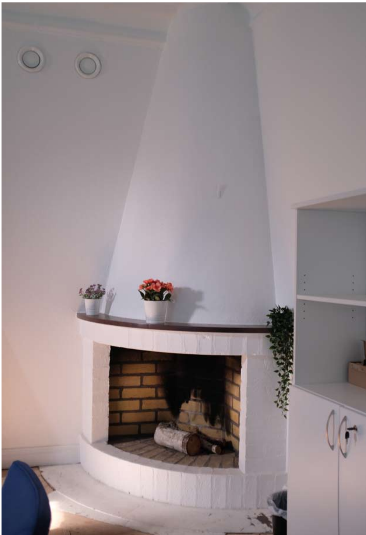
Eldstad av 1950-talstyp på plan 1. Den vita kulören är sekundär, teglet har sannolikt varit omålat i den nedre delen. Spiselkrans i jämtländsk kalksten.
