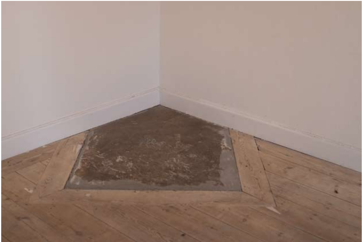
Lämning efter en borttagen kakelugn i golvet på plan 1. Brädgolvet är ett undergolv som inte ursprungligen varit synligt. Det har varit täckt av parkett eller linoleummatta.
