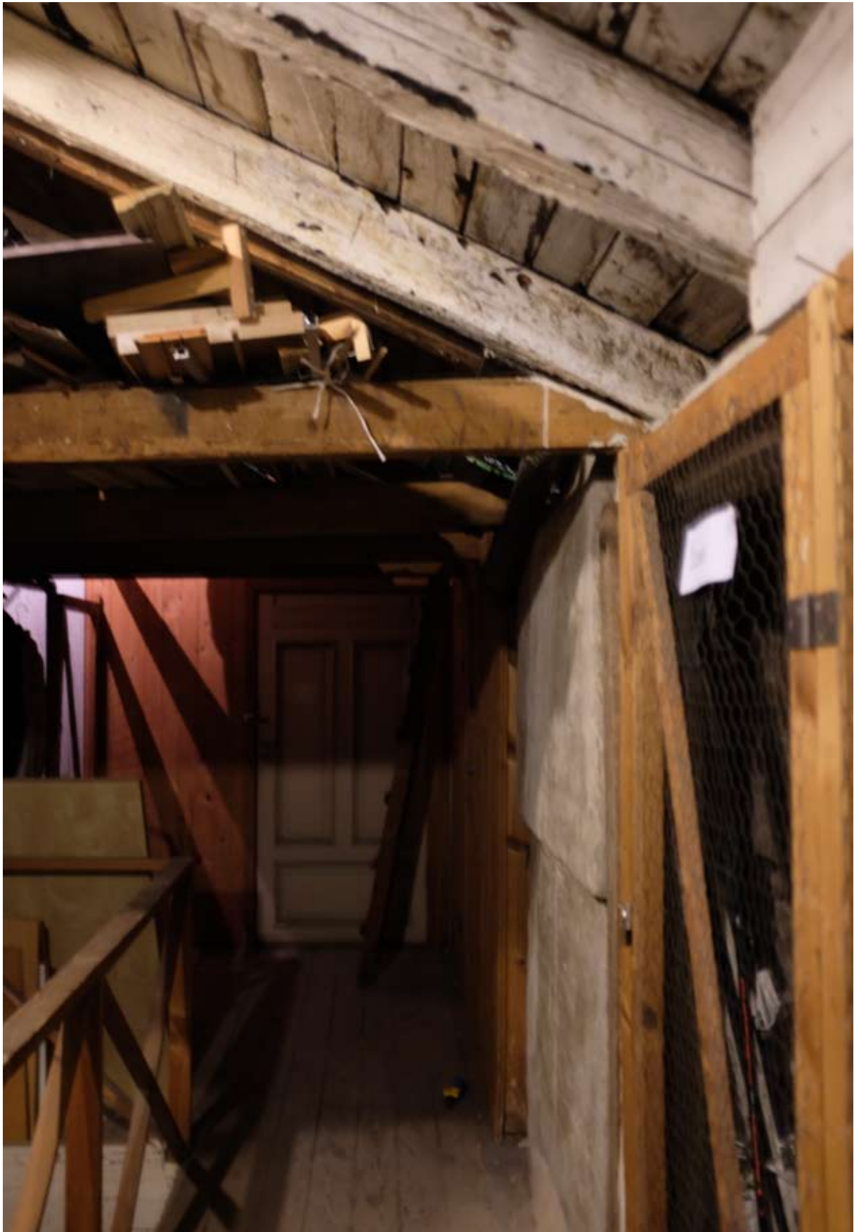
Intreior från vinden. Vinden har aldrig varit inredd, och har en ålderdomlig karaktär. I fonden skymtar en spegeldörr av samma typ som på de övre våningsplanen i byggnaden.
