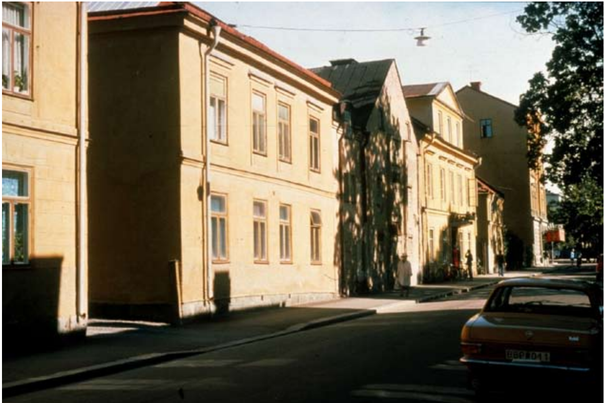
Kvarteret Njord från Salagatan mot Vaksala torg 1976. Kvarngärdet 35:3 skymtar längst bort. Foto Ola Ehn 1970. Upplandsmuseet.
