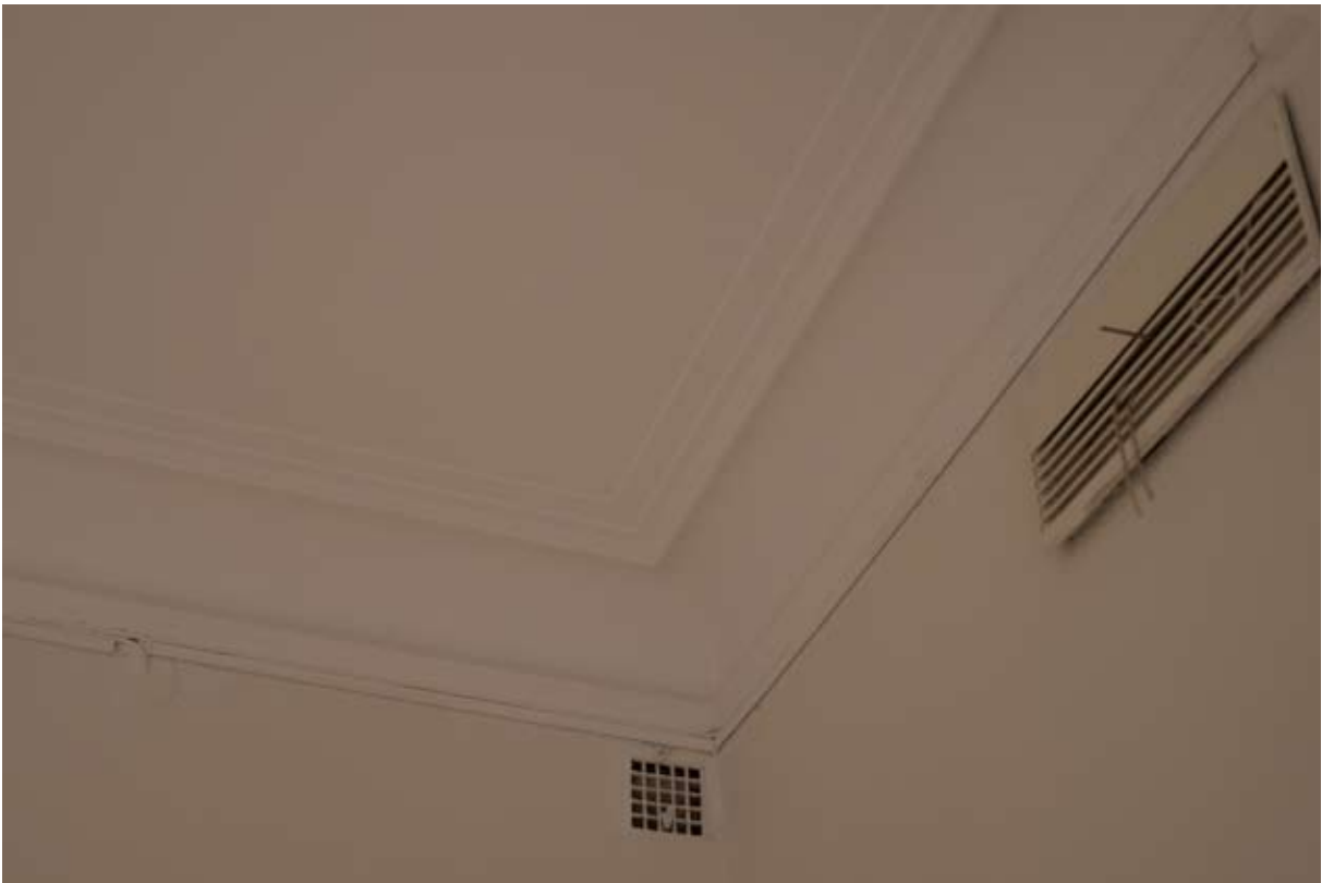
Detalj av hörn i boningsrum. Taklist i form av profilerad hålkål, sannolikt förtillverkad i stucc. Nederst i mitten ett äldre ventilationsgaller, till höger ett nyare. Nedanför taklisten sitter en kabelränna i plast.
