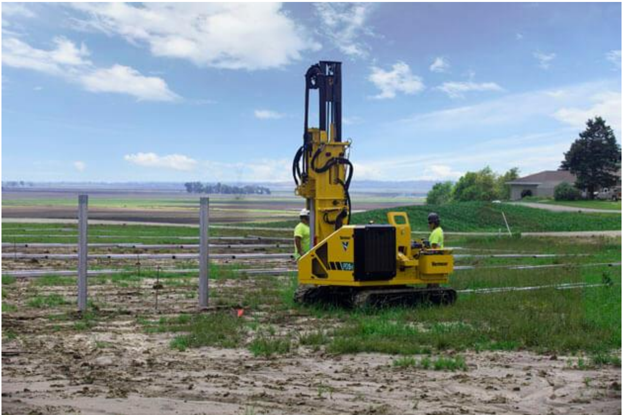
Figur 9-Exempel på pålningsmaskin på larvfötter för installation av pålar för stängsel och markställningar.
