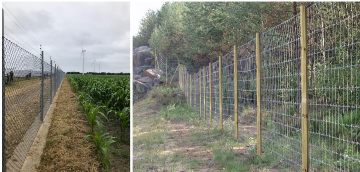
Figur 6-Exempel på utförande av industristängsel med invändigt överklättringsskydd i form av eltrådar (vänster). Exempel på viltstängsel på trästolpar och utan överklättringsskydd (höger).
