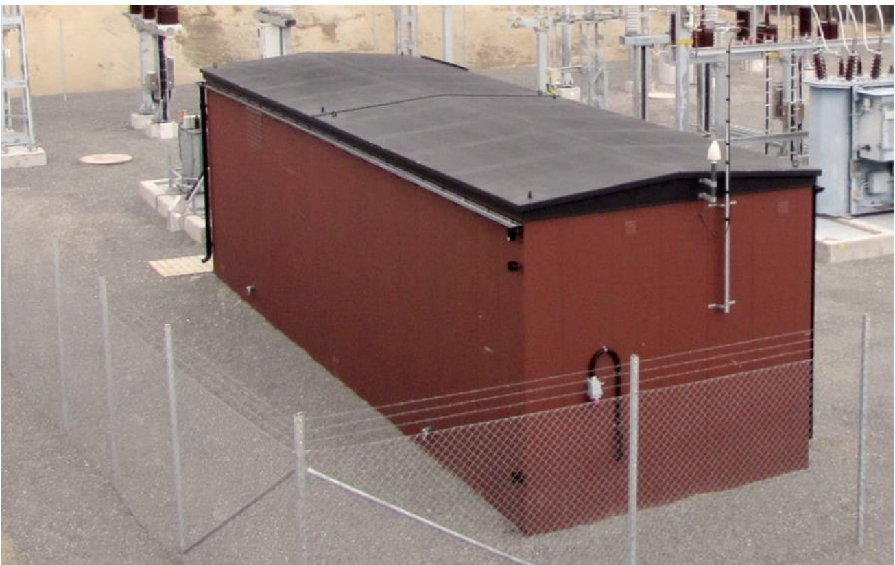
Figur 12-Exempel på mottagningsstation.
