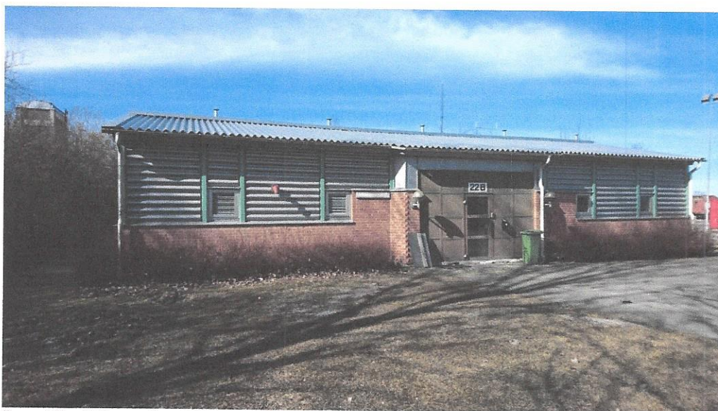
Byggnad Grovlektion exteriör
