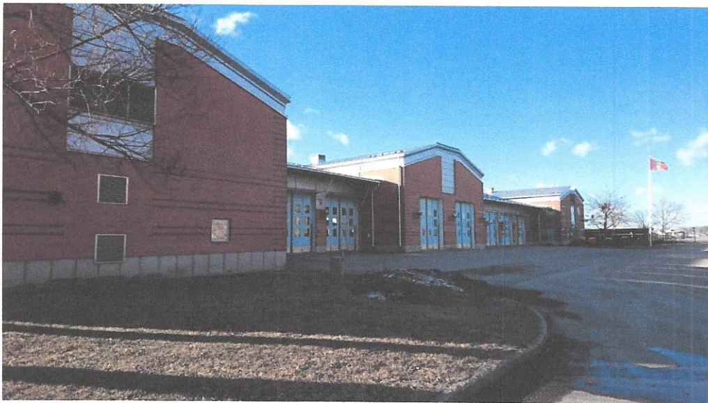
Byggnad Brandstation, exteriör fasad öster med garageportar
