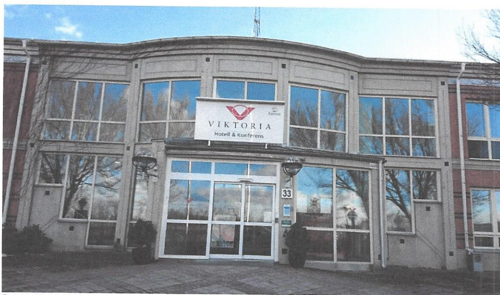
Byggnad kontorsbus, exteriör, fasad gemensam entré
