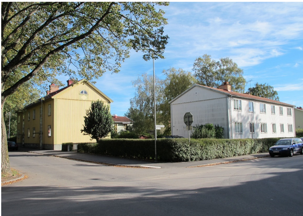
Bild 4. Foto från september 2015 som visar befintlig byggnad inom planområdet, samt gaveln på det intilliggande bostadshuset som är ritat av Gunnar Leche.
