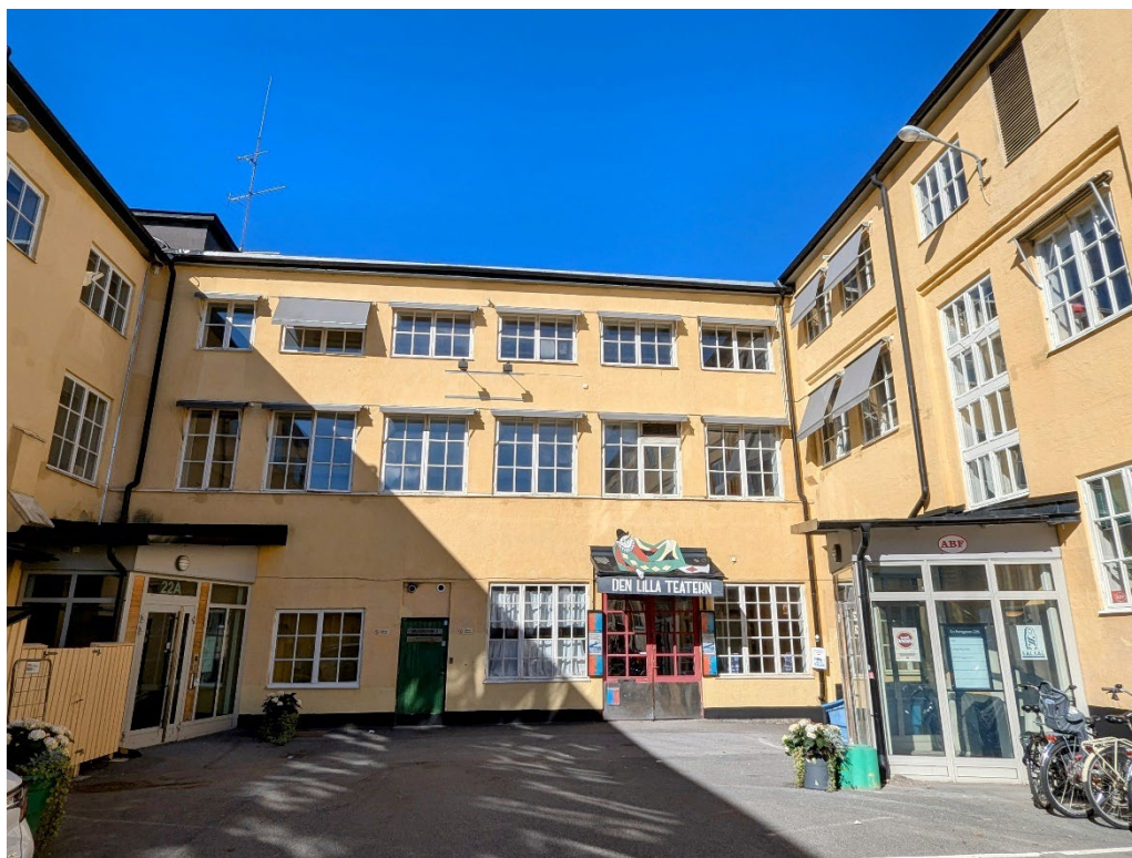
Bild 4 Innergården sedd från S:t Persgatan.
