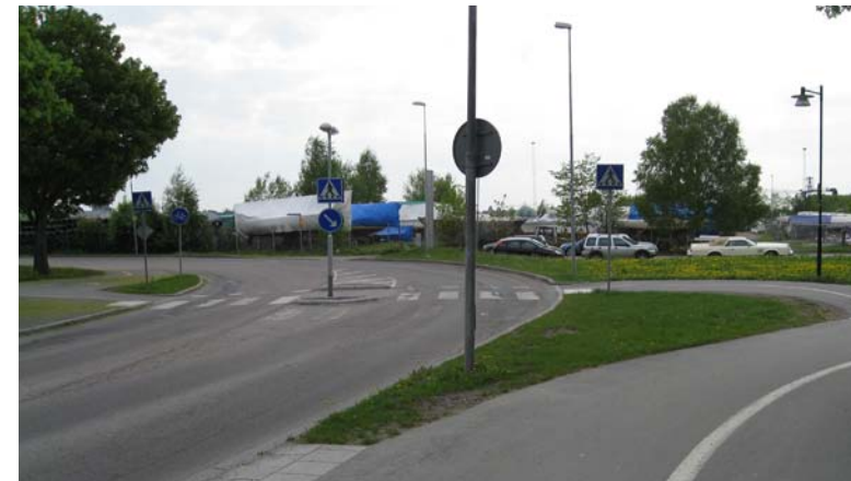
Östra Ågatans anslutning till Kungsängesplanaden, nuvarande utformning (Foto Bjerking AB)
