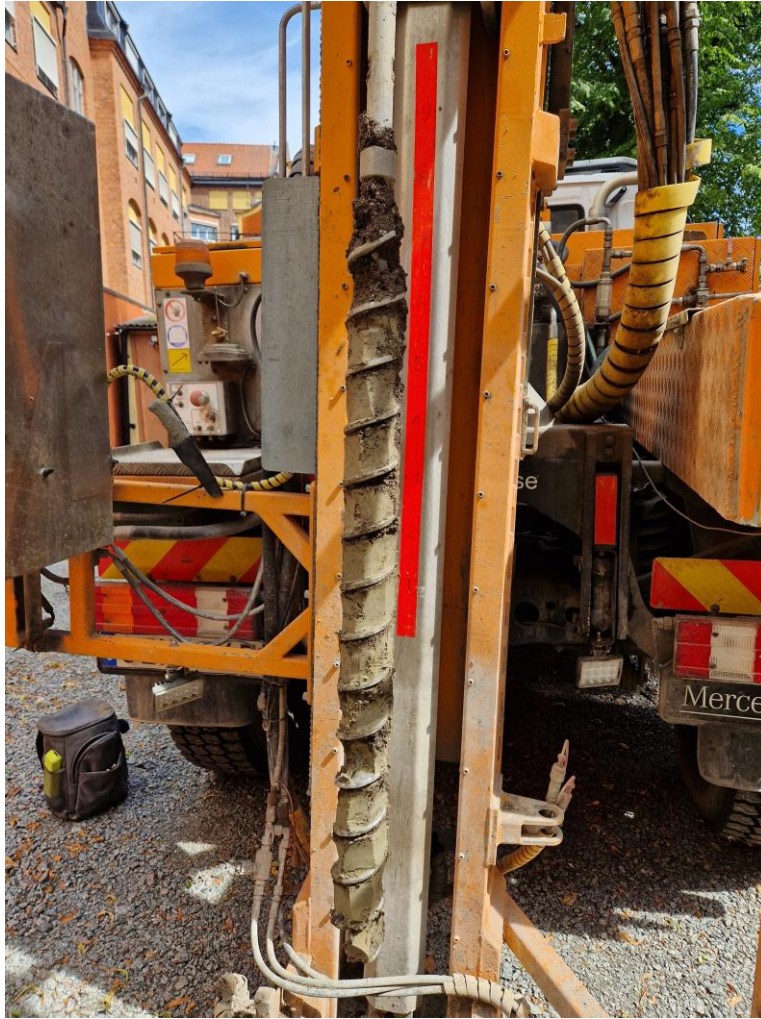
Exempel på skruvprov av fyllning samt underliggande lera.
