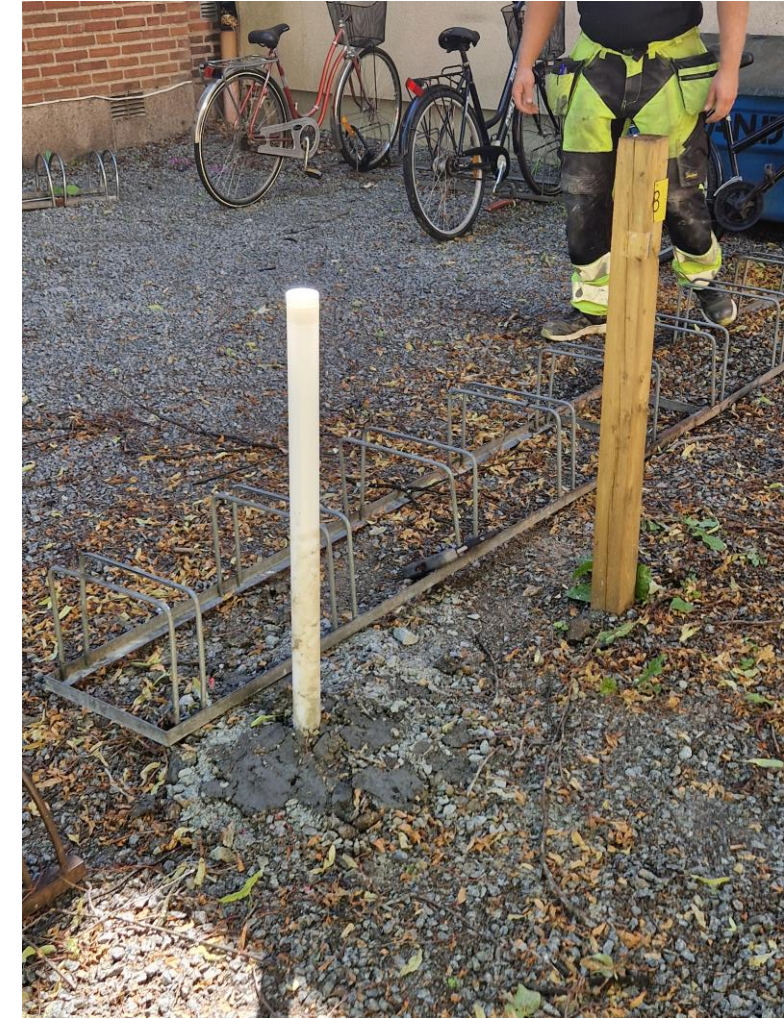
Installerat grundvattenrör i skruvhål (punkt 25B05)
