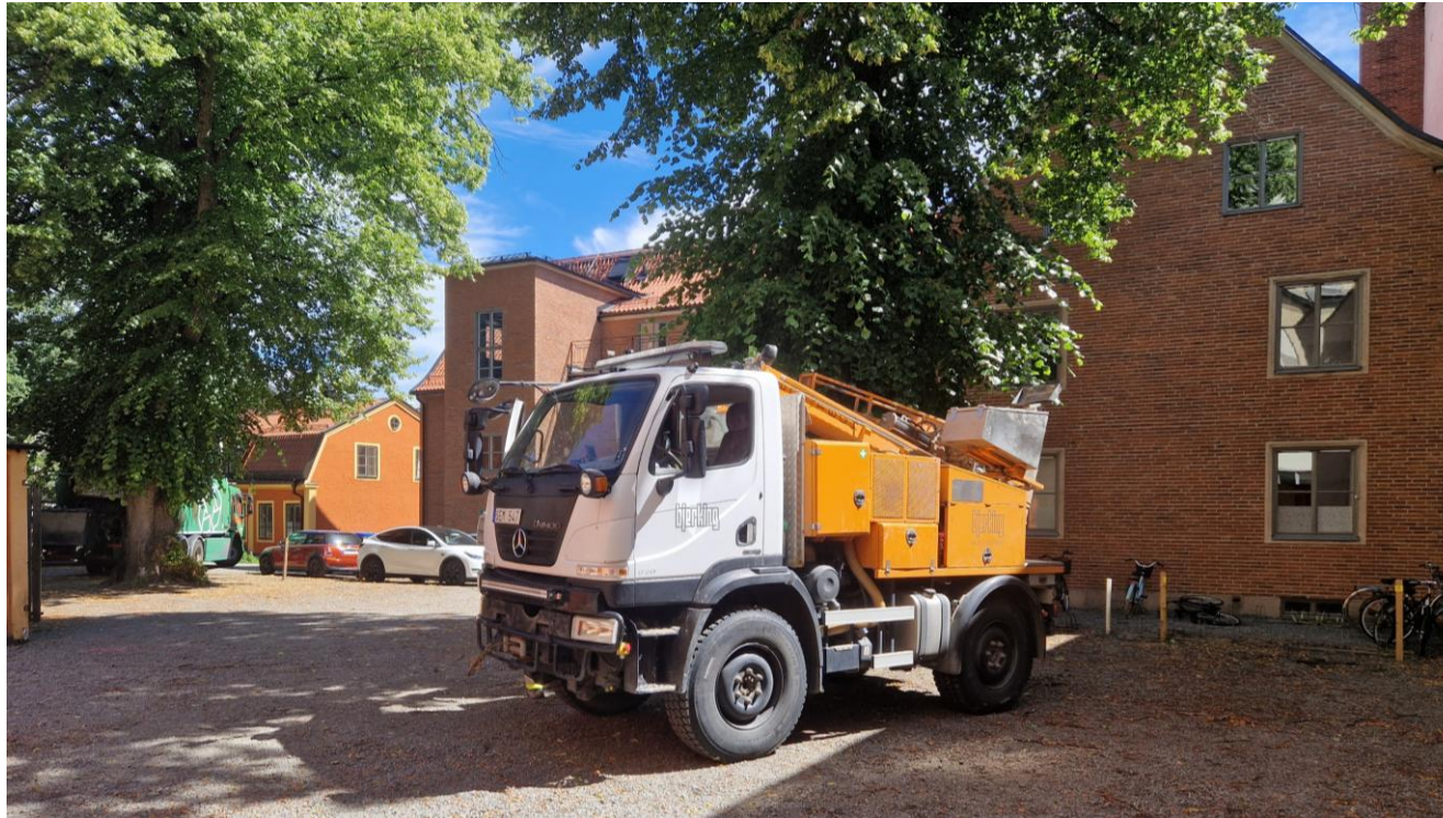
Miljöteknisk markundersökning med borrhvagn (Unimog).
