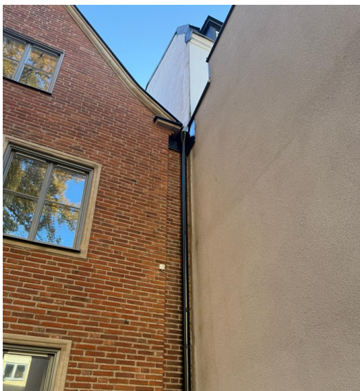
Figur 9. Sadeltak mot intilliggande fastighet i sydväst.
