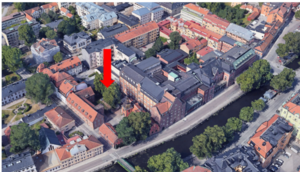
Figur 6 Kvarteret Kaniken sett snett ovanifrån från sydöst. Röd pil visar den nya byggnadens placering.
