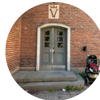
Entréparti med trädörr, omfattning av profilerad natursten som möter trappen av natursten. Ovan porten ornament med enkelt V och krona.
