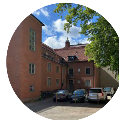
Byggnadens uppbrutna fasad in mot gården
