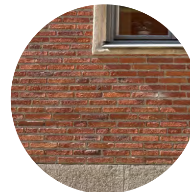
Samspelet mellan den rustiserade betongsockeln, teglet och de profilerade fönsteromfattningarna.
