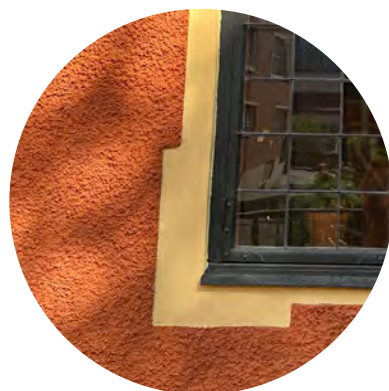
Fasader med puts innehållande grov ballast avfärgad i orange kulör. Slätputsade omfattningar i gult.
