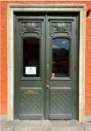
Vindfångets gamla dörrar finns bevarade i nytt läge som byggnadens huvudentré.
