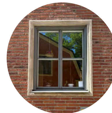
Träfönster med mittpost och två luf- tar per båge. Omfattningen av fasad betong.
