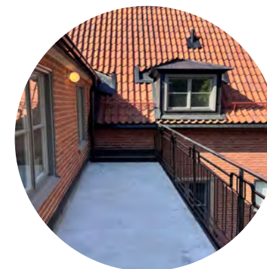
Kungsbalkongen med sitt klassiska 1950-talsräcke i svart stål.
