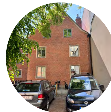
Att fasaden ut mot dagens parkering har fönster (det vill säga inte är en brandgavel)
