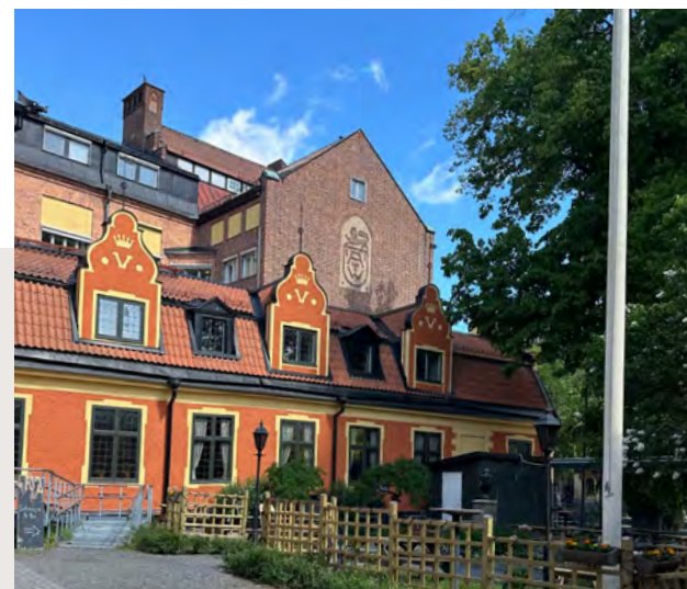
Ovan: Nationshusets många årsringar tar sig uttryck i fönster, vindskupor, färgsättning, det brutna taket m.m.
