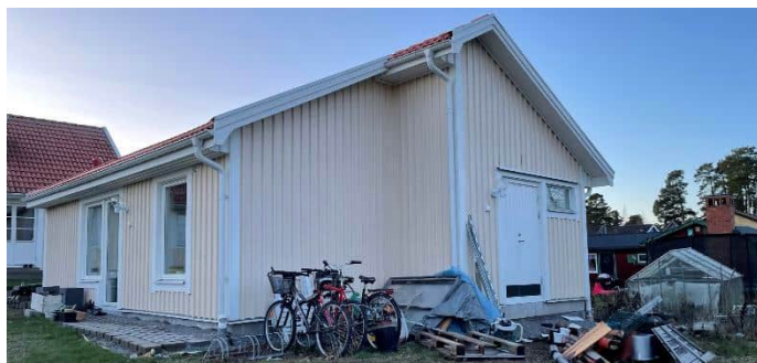
Figur 12 Nybyggd bostadshus som används som bostad på fastigheten Bergsbrunna 14:126.
