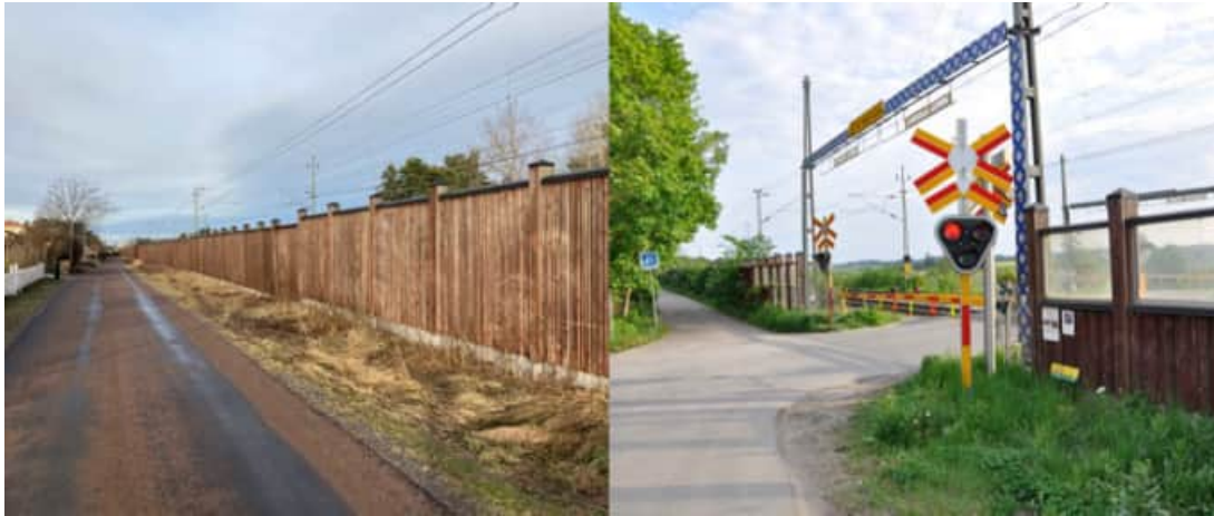
Figur 4. Befintlig bullerskyddsskärm i Bergsbrunna. Till vänster visas en del av skärmen längs Banvägen. Till höger visas skärmens öppning vid Gårdsvägen.
