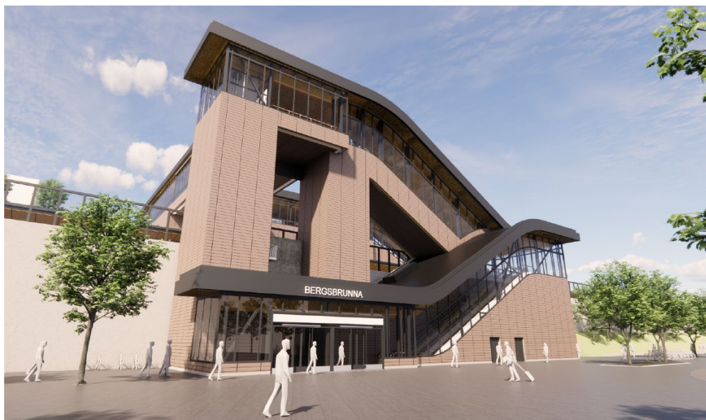
Figur 10: Järnvägsstationens entré på östra sidan. På grund av höjdskillnaden leder rulltrapporna och hissarna resenärerna upp över spåren och till perrongerna. Bild: Sweco.
