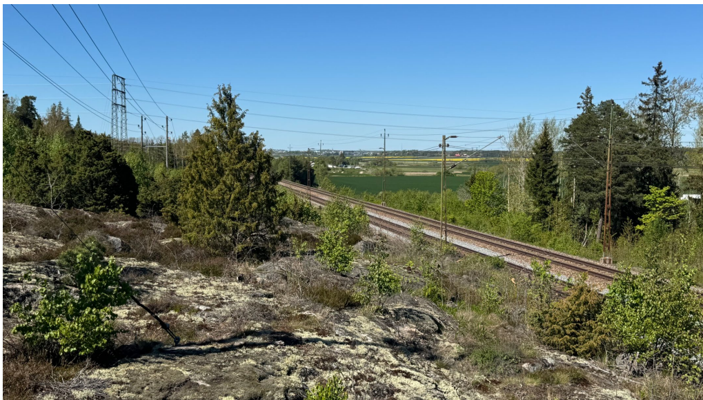
Figur 8: Foto taget norrut från västra sidan järnvägen. Kraftledningarna längs med järnvägen syns till vänster i bild. Skogsdungen på östra sidan om järnvägen kommer att tas bort i och med att järnvägen utökas med två spår. Fotot visar höjdskillnaden i området.
