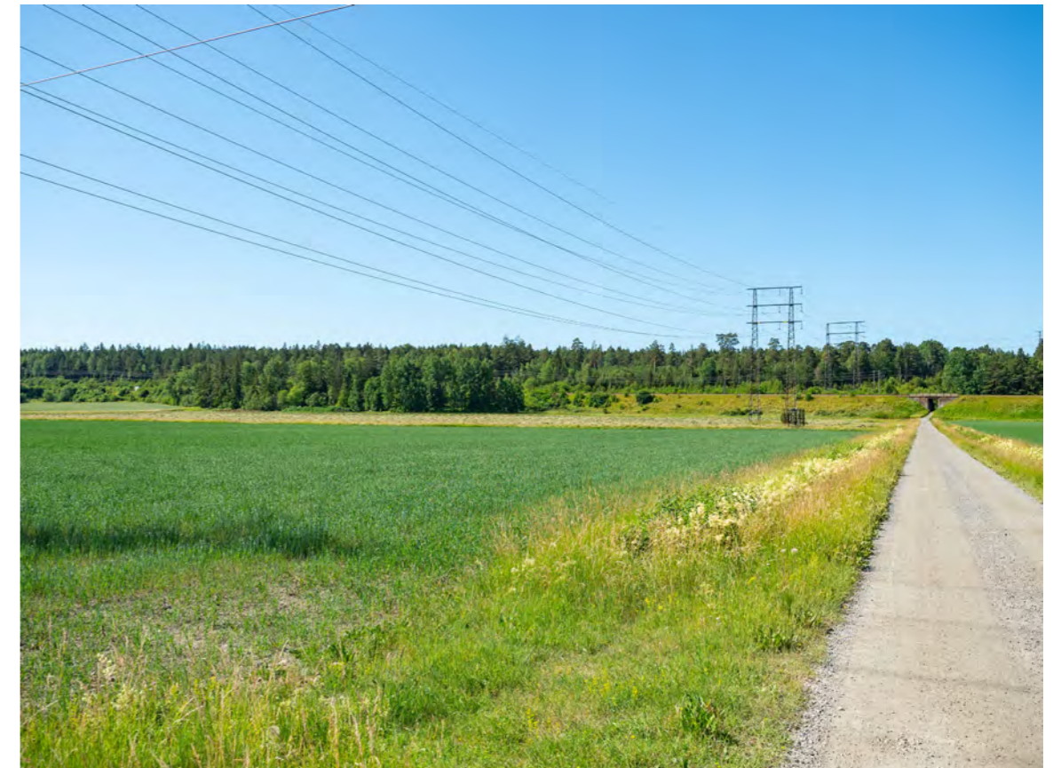
Befintlig vägport syns till höger i bild. Vy mot järnvägen och Lunsen.
