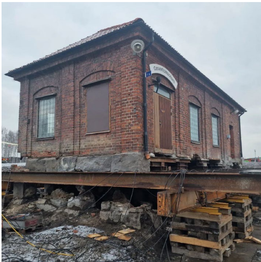
Figur 13. Bilden visar flytt av en byggnad med löst sammansatt grundmur. Flytt av gasmästarkontoret i Norrköping. Foto: Trafikverket
