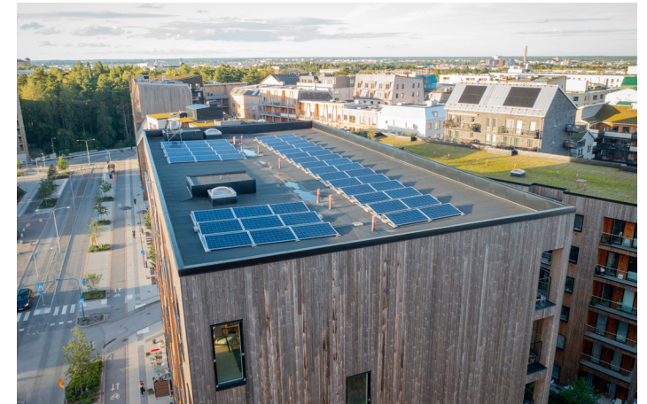
Exempel på solceller på taket.
