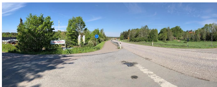
Figur 2-4. Gång- och cykelbanan längs med väg 282.
