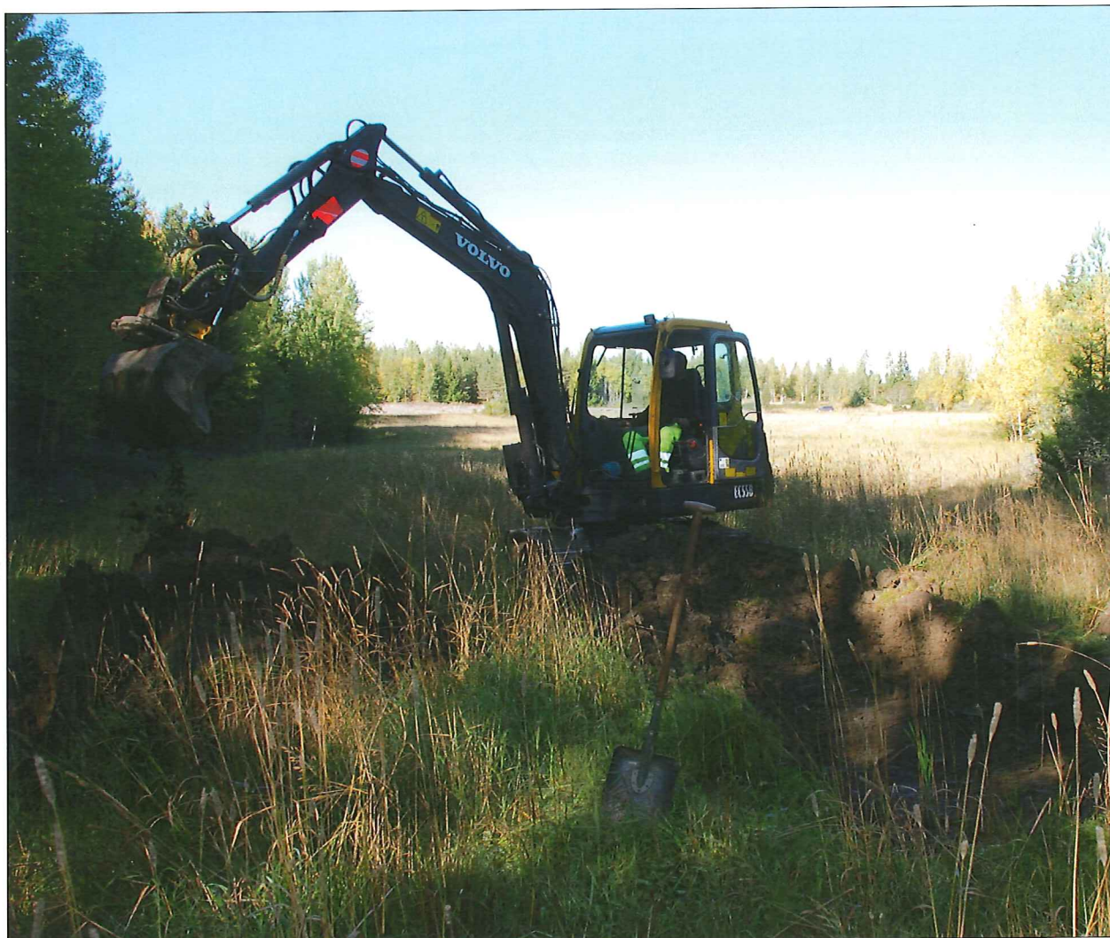
Figur 13. Vy och arbetsbild över schaktningsarbete vid objekt 1. I förgrunden arbetar arkeologen Annika Nordström och maskinisten Fredrik Bonnevier med att ta upp schakt. Foto från sydöst: Niclas Björck.
