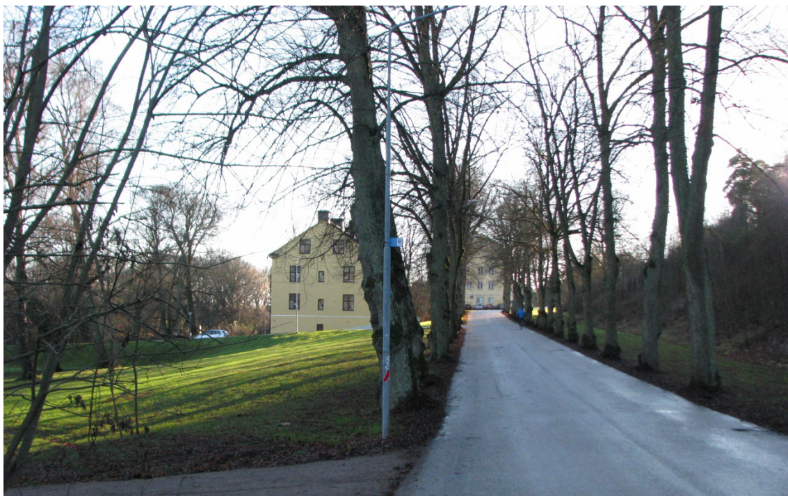
Kronbränneriets två kvarvarande byggnader vid Ulleråkersvägen.
