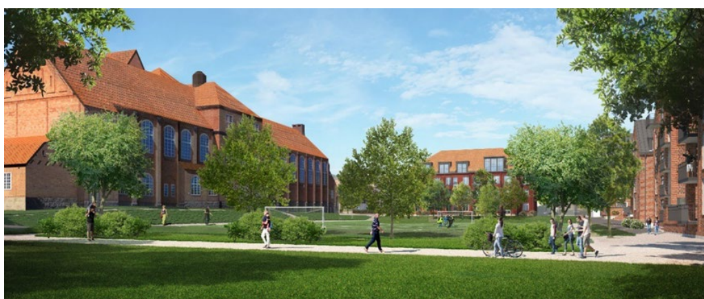
Bild 31 Vy över fotbollsplanen med Seminariebyggnaden till vänster, ny träbyggnad i mitten och den nya tegelbyggnaden till höger. Illustration: ÅWL arkitekter.
