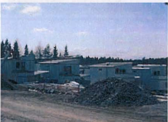
Vretalund under uppbyggnad.
