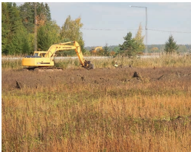
FIGUR 4. Schaktningen pågick på båda sidor av Bärbyleden. Från sydöst. Foto: Ann Lindkvist.
