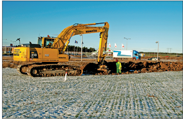
Fig. 12. Schaktning på norra änden av område 3. Torbjörn Jakobsson Holback står framför kameran och grävmaskinisten Victor Ekstrand sitter i maskinen. Foto från sydost: Thomas Eriksson.
