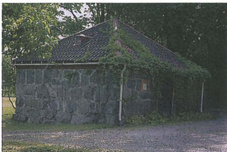
Fruktkällaren (foto: Hanna Schill, byggnadsantikvarie)
