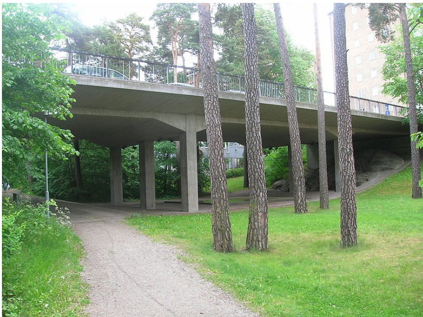
Exempel på bro/passage vid Etsarvägen, Johanneshov, Stockholm.
