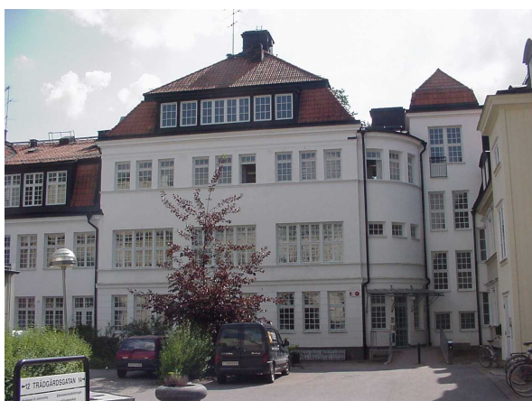
Foto över gården, med det putsade huset i fonden.
