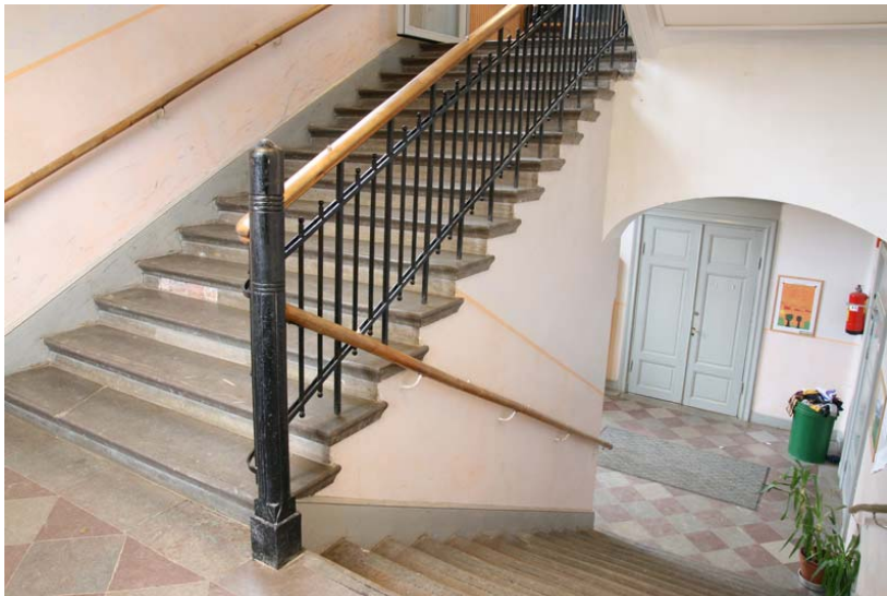
Foto som visar trapphus i Sverkerskolans huvudbyggnad (Upplandsmuseet)
