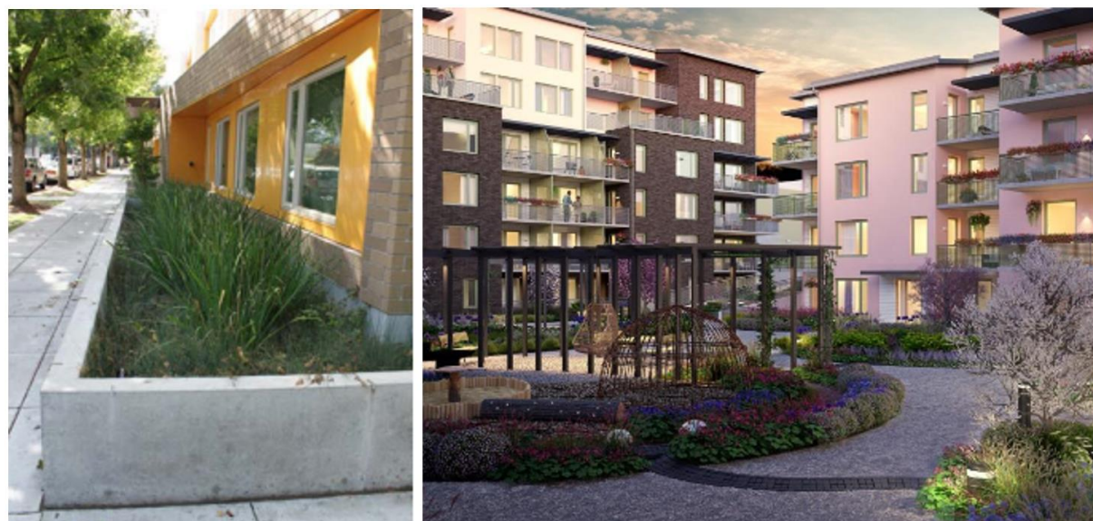
Figur 11. Vänster bild: Upphöjda växtbäddar kan anläggas intill en byggnad för att ta hand om takdagvatten som leds dit via stuprör (bild från Stockholm vatten och avfall). Höger bild: Växtbäddar på innergård (bild från Uppsalahem).
