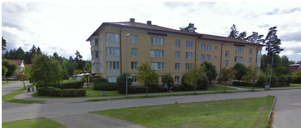
Bild 5 Planområdet sett från Västgötaresan mot sydväst med vårdboendet i fronten.
