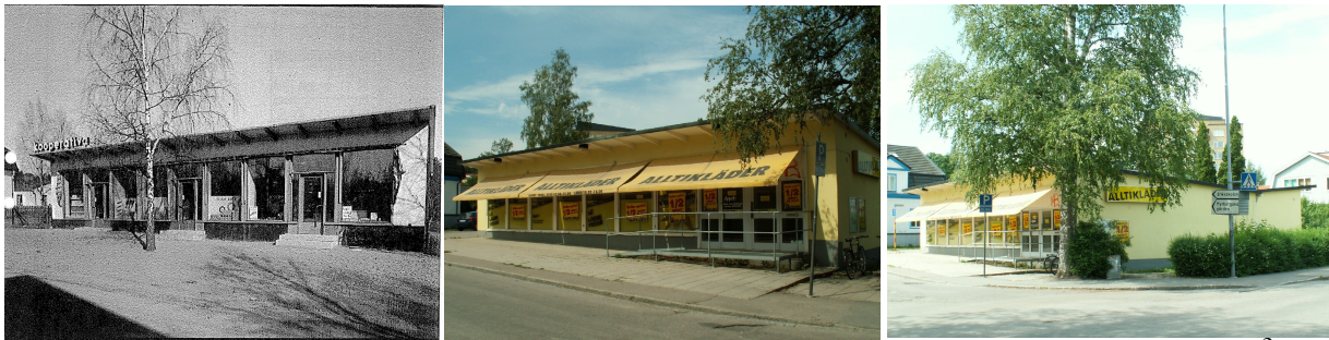
1. Byggnad i ursprungsskick (bild 1) samt nuvarande utformning (bild 2,3)
