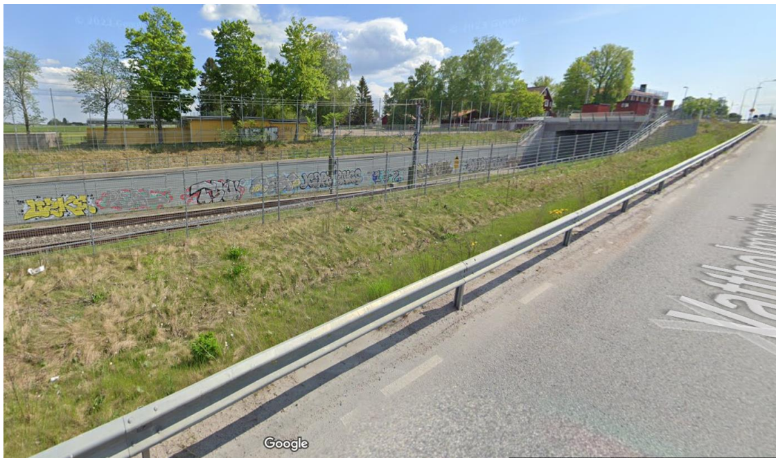
Figur 4. Stödmur och infart i tunnel längs med södra delen av fastigheten. (Källa: Google maps)
