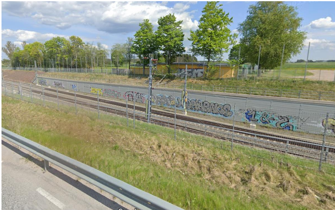
Figur 3. Vall och stödmur längs med norra delen av fastigheten. (Källa: Google maps)
