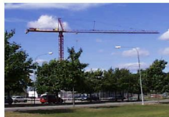
Under byggskedet skapas barriärer som förändrar människors rörelsemönster. Arbetsredskap tar i anspråk mark och tillfälliga vägomläggningar krävs.
