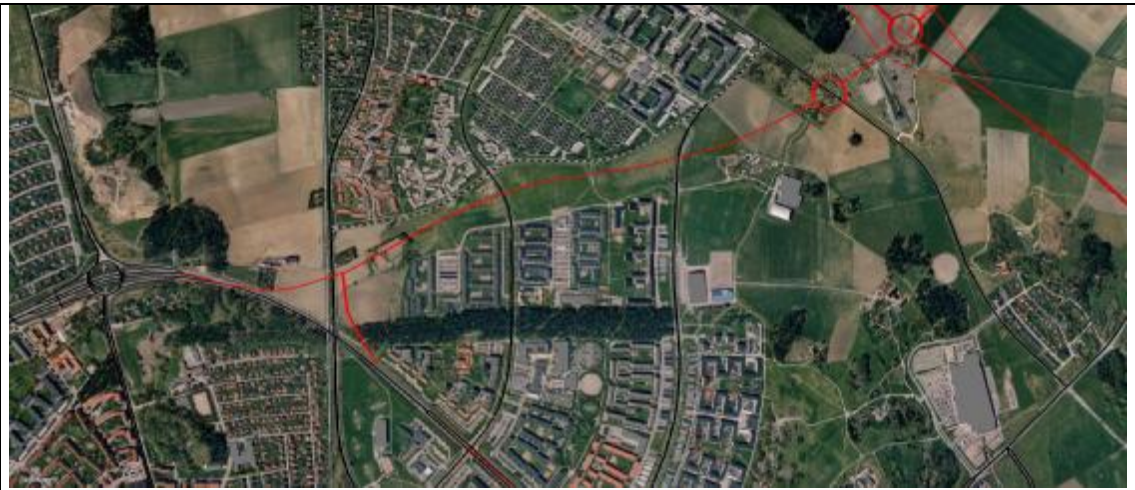
Flygfoto år 1998. Bilden visar Bärbyleden 3 mellan Röbo trafikplats och ny E4.
