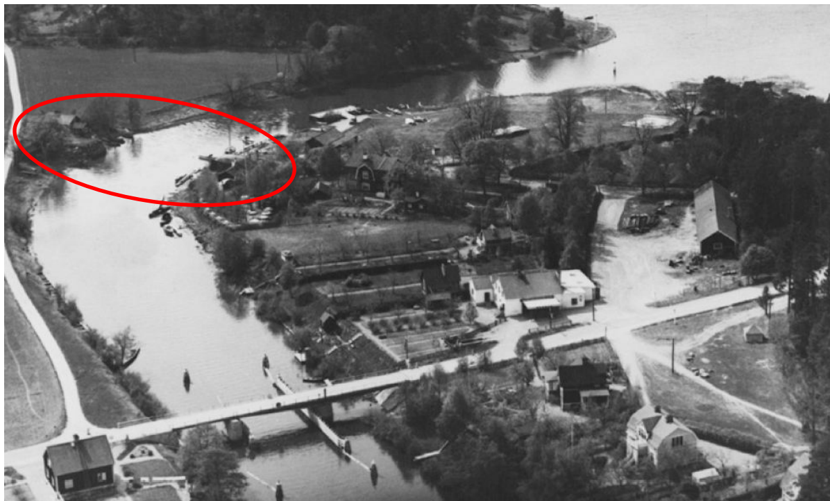
Gammalt flygfoto över Flottsundsbron i riktning mot syd. Nere till vänster syns brovaktarstugan som brann ner 1985. Uppe till vänster, inom röd markering, syns det gamla brofästet från Prins Gustafs bro. Foto: Oscar Bladh, någon gång mellan 1932–1937.
