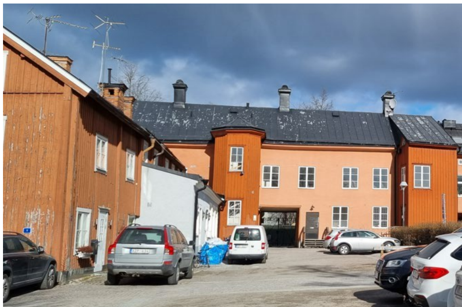
Figur 23 Gården inom Dragarbrunn 3:3. Rakt fram i bilden syns hus A med dess trapphus.
