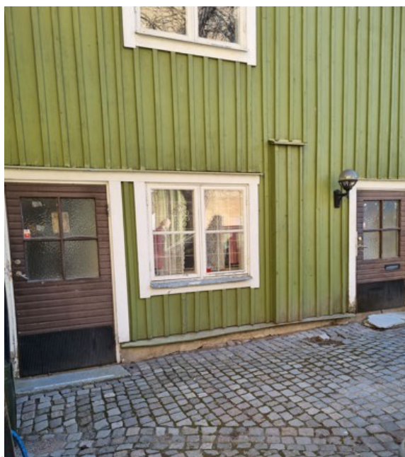
Figur 20 Del av hus D inom Dragarbrunn 3:2, sett från gården.
