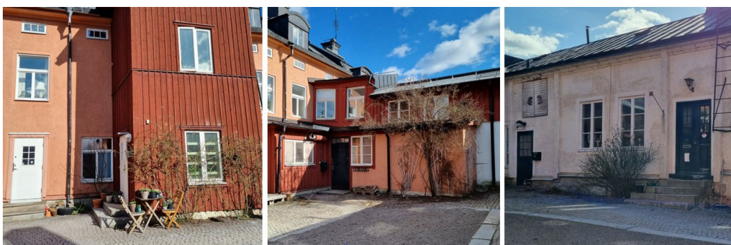
Figur 71 Bilder på en del av den växtlighet som finns inom kvarteret.
