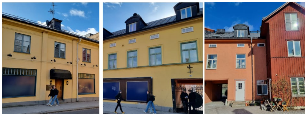
Figur 40 Exempel på färgsättning av fasader inom kvarteret Lindormen.
