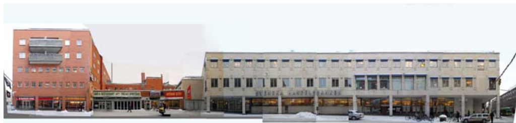
Kontor/bost. 5 vån Terrasserad byggnad Kvarteret längs Dragarbrunnsgatan
