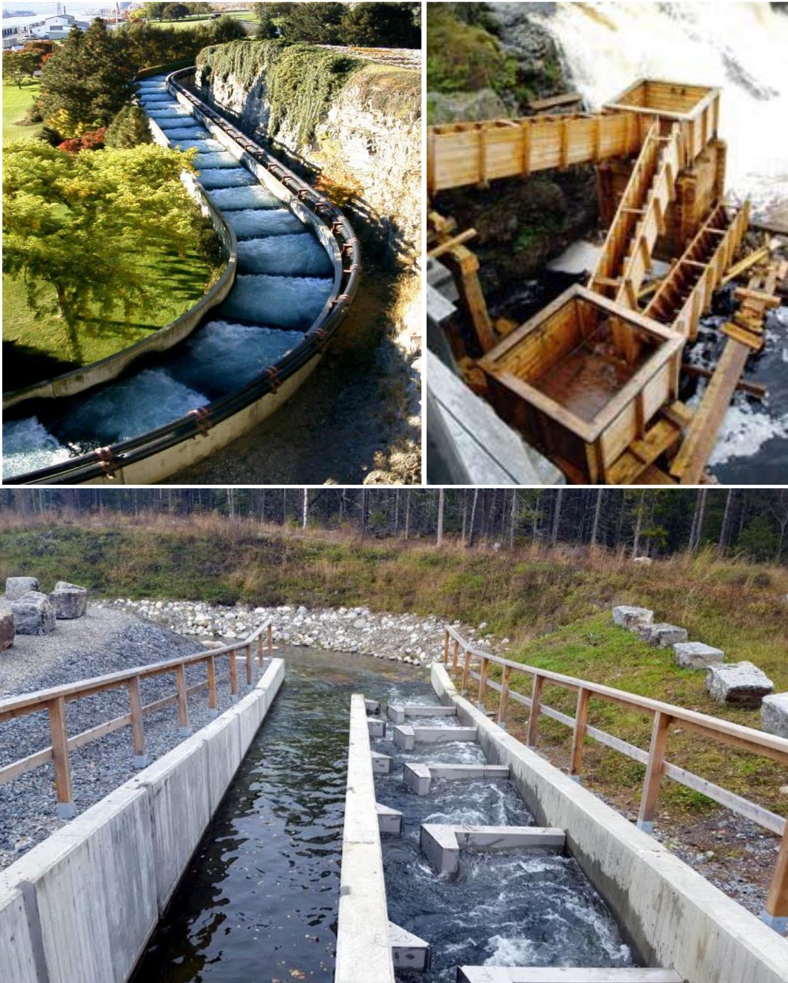
Figur 40. Ovan t.v: Bassängtrappa i Columbiafloden, USA (Havs- och vattenmyndigheten, 2013a). Ovan t.h: Denilränna/motströmsränna. Lameller sitter i 45° vinkel mot botten och dess öppning bör vara minst 20 cm, helst 30 cm (Naturvårdsverket och Fiskeriverket, 2008). Nedan: Slitsränna i Billstaån, Östersund. Fisken vandrar genom de smala slitsarna till höger i bild. Foto: WRS.
