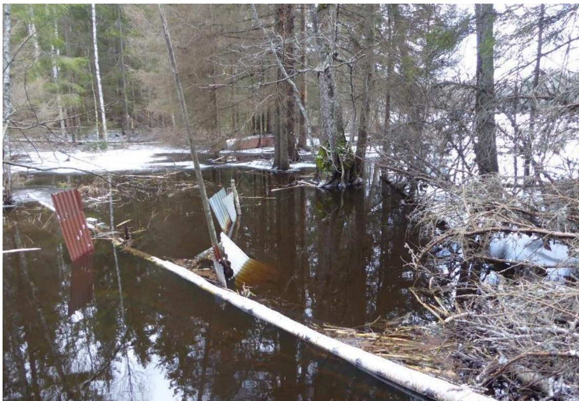
Figur 37. Stensjöns utlopp ligger högt upp i Lejstaåns avrinningsområde. Vattennivån vid fältbesök (2021-03-19) var högt. Inget dämme noterades vid utloppet, endast rester av takplåt och stockar.
