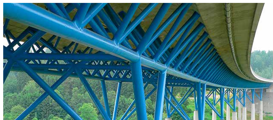
Autobahnbrücke St. Kilian
