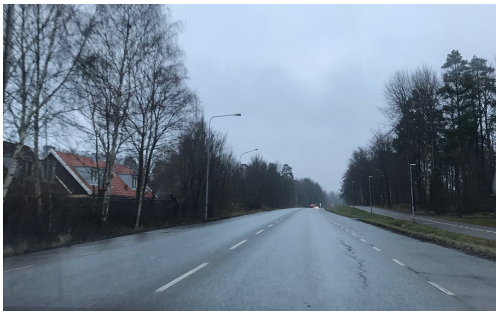
Bild 8 Vårdsätravägen sedd från söder. Den befintliga vägen kommer att breddas. Kollektivtrafikstråket är tänkt att placeras i mitten av gatuutrymmet. Visst intrång kommer att ske på några befintliga småhusfastigheter. Ett antal befintliga träd kommer tas bort, men biotopskyddade träd ersätts av nya.
