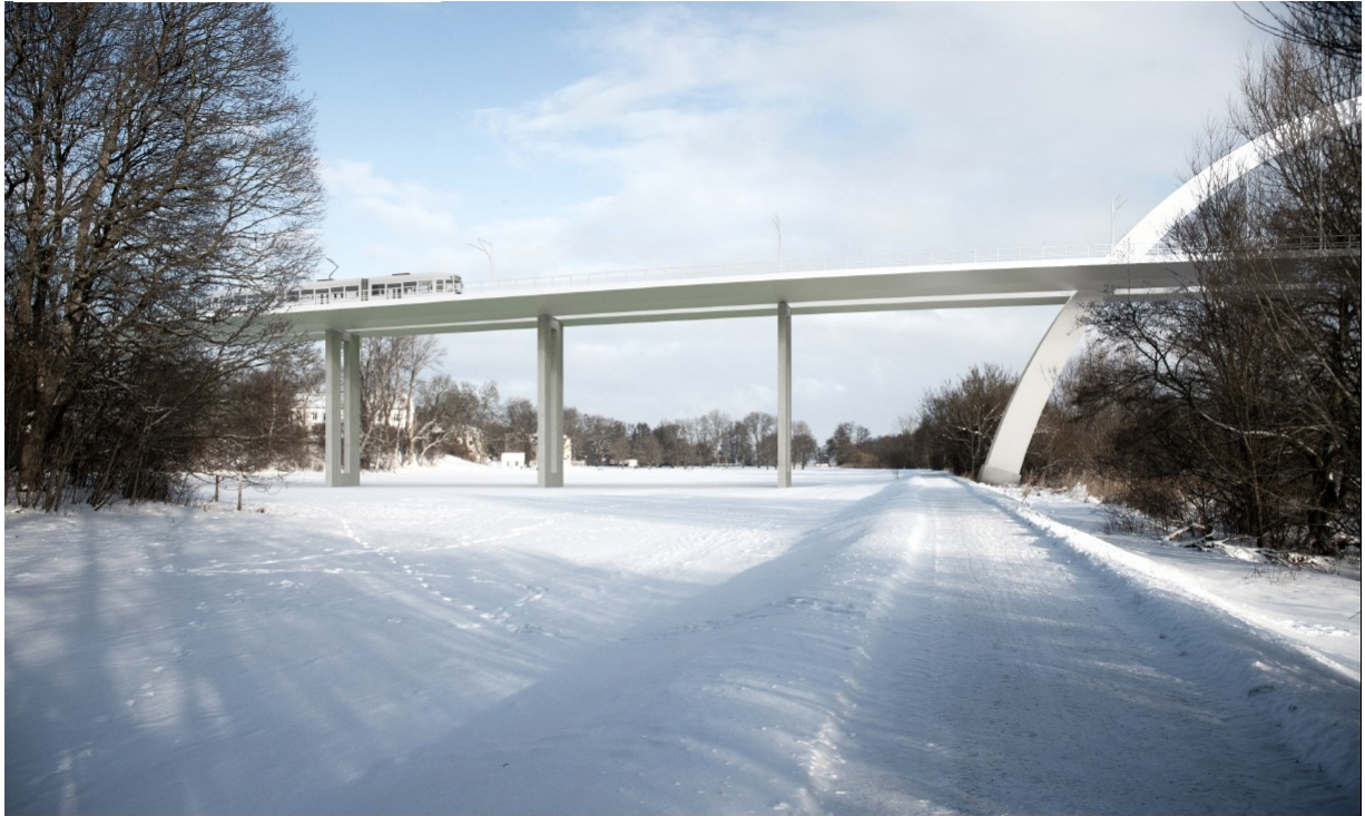
Vy från söder, strax väster om Fyrisån, som redovisar en exempelillustration för broalternativ B. Här syns brokonstruktionens placering och höjd i förhållande till gång- och cykelstråket utmed Fyrisån. Brokonstruktionen är utformad med en pelar-balkstruktur i form av en bågbro (Bjerking och Rundquist).
