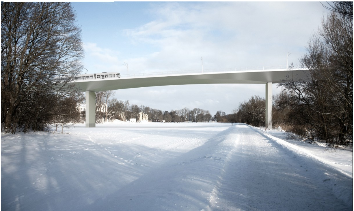
Vy från söder, utmed gång- och cykelstråket utmed Fyrisåns västra sida, som redovisar en exempelillustration för broalternativ B. Brokonstruktionen är smäckert utformad med en pelar-balkstruktur (Bjerking och Rundquist).
