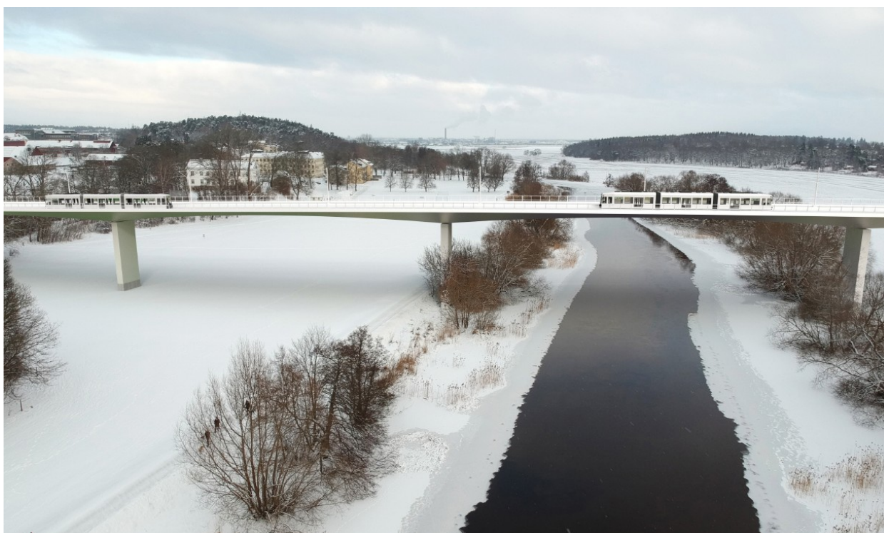
Vy från söder, Fyrisån, som redovisar en exempelillustration för broalternativ B. Brokonstruktionen med en enkel pelar-balkstruktur (Bjerking och Rundquist).
