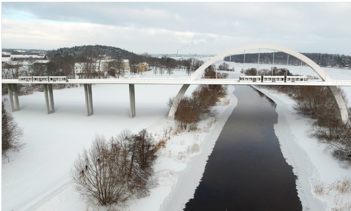
Vy från söder, Fyrisån, som redovisar en exempelillustration för broalternativ B. Brokonstruktionen med en enkel pelar-balkstruktur i form av en bågbro (Bjerking och Rundquist).
