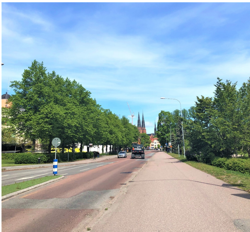
Figur 52. Sjukhusvägen med Stadsträdgården till höger i bild och domkyrkan i fonden. Vy från söder. Foto: White arkitekter.
